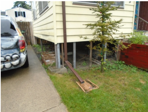
HDF-2017-5836-NEP, 510 N. Grant St., Porch Repairs BEFORE
